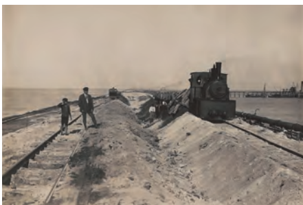
99 Jahre ist das her. Der Bau des Syltdamms soll 2027 gefeiert werden.
