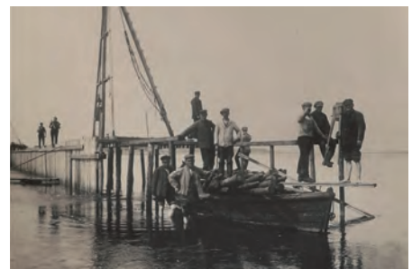
Die Bauarbeiter vor 100 Jahren – hier beim Einsatz der Spundwände.
