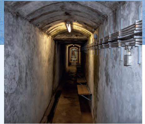
200 Meter beklemmende Bunkerstollen geben heute noch Einblick in die Zeit des Zweiten Weltkriegs.
