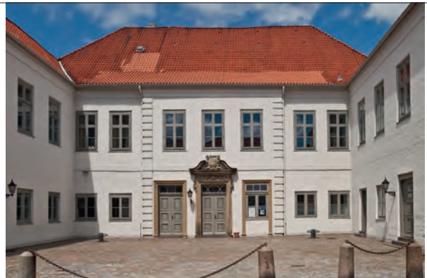
Das zwischen 1708 und 1710 errichtete „Wasmer-Palais“ wird durch die Volkshochschule und die Musikschule genutzt.
