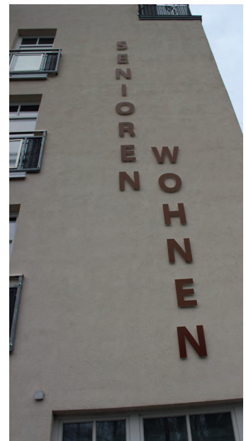
Foto: Haus Schleusberg
