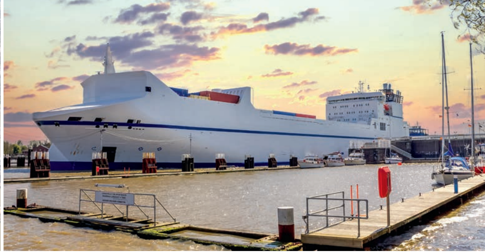
Damit auch in Zukunft Schiffe den Nord-Ostsee-Kanal passieren können, wird die 5. Schleusenammer erstellt. Wenn sie einsatzbereit ist, werden die anderen Kammern saniert.
