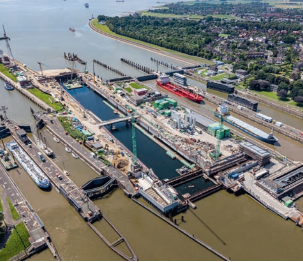
Die Schleuse von oben. Der Bau der 5. Schleusenammer ist bald fertiggestellt.
