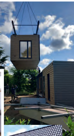
Die Module werden komplett vorbereitet und innerhalb eines Tages aufgestellt - wie z. B. hier 1,5 Woodees.
